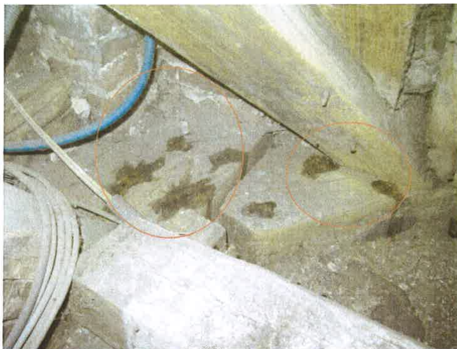
Les perçages sont doublés aux encastresments (entraits, pannes ...).
