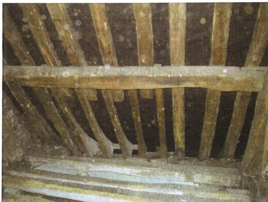
Vue sur les charpentes après la préparation des bois.
